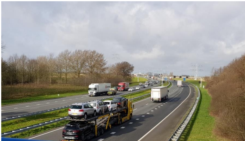
Figuur 4: De A58 vlak voor de tunnelmond (vanaf aansluiting 33)
